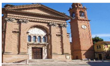
Chiesa S. EGIDIO ABATE Cavezzo (MO)
